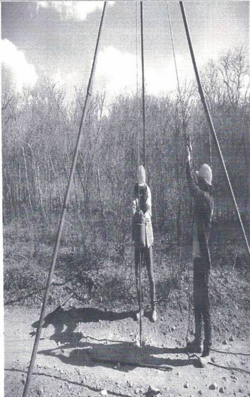
Foto 02: Furo realização de SPT
