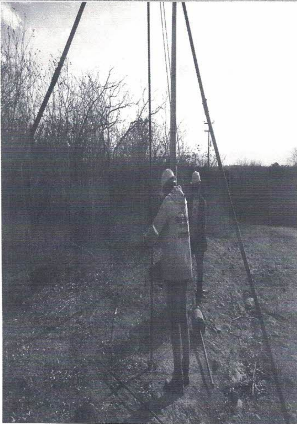
Foto 01: Realização de SPT
