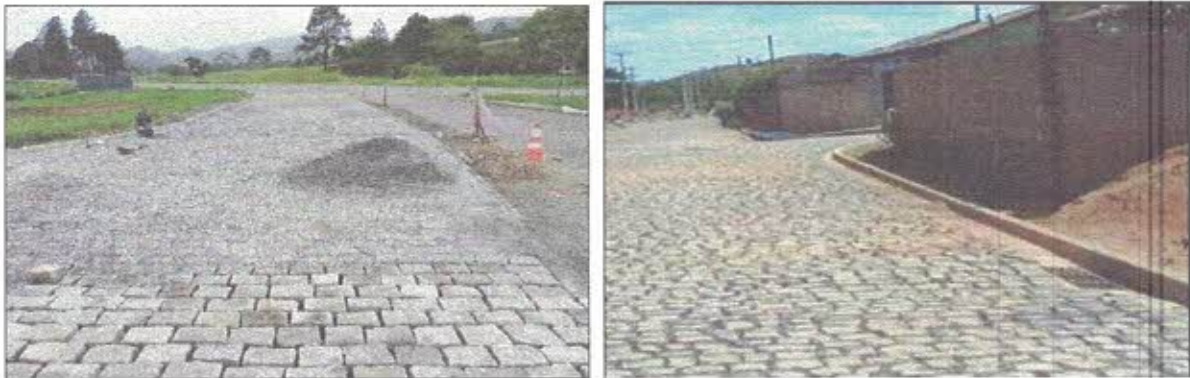
Figura 16 – Imagens Ilustrativas Obras de Pavimentação
