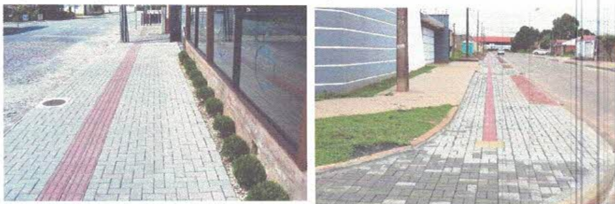
Figura 18 – Imagens Ilustrativas Obras de Pavimentação de Piso Intertravado
