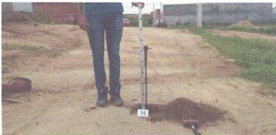
Foto 21 – Aspecto de Sondagem S 16 em 453.119 / 9.358.721.
