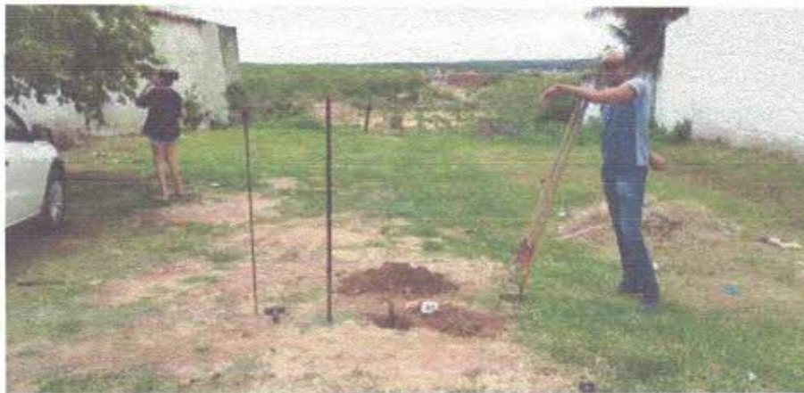
Foto 01 – Aspecto geral do percurso do arruamento.
