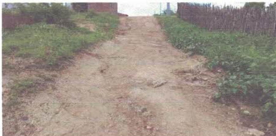
Foto 19 – Aspecto de trecho entre S 14 e S 15 com solo argiloso raso sobre rocha alterada.
