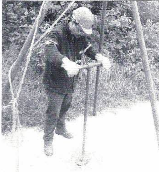
Foto 03: Furo realização de SPT
