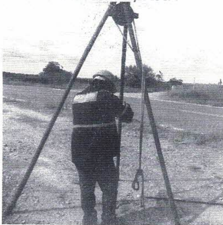
Foto 04: Estrada onde será realizado a obra de Abastecimento
